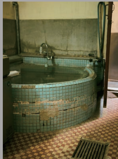
数家族が住み込みで働いていた名残の古い浴槽。映画のセットのような設備があちこちに残っています。
