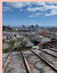
屋根の上にも世界はある
