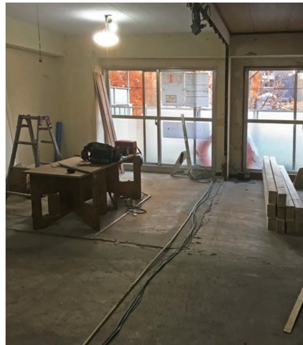
解体工事後の現場。壁や床が全部取り除かれている状態です。
