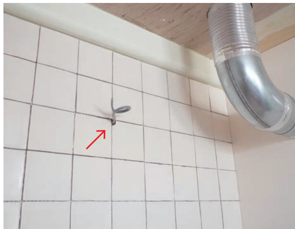
張り付けられたタイル。綺麗に目地から線が出ています。
