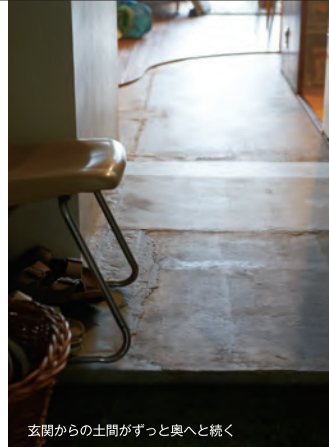
玄関からの土間がずっと奥へと続く
