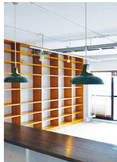
a, a' | 電気配線はすべて鉄管を通してコンクリート天井に露出配管。エアコンは業務用をボルトで吊り下げた。配線用ラックも本来は駅やビルで使われる“超”業務用。床にナラ材を使ったのは、「フローリングの定番だから」
