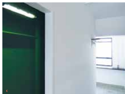
c, c' | タイル、土間、左官、塗装と工法は全て昔ながらの“湿式工法”。昔ながらの素材で普通に作り上げる手法を全ての場面で採用。ちらりと見える照明も鎮でつりさげるタイプの蛍光灯
